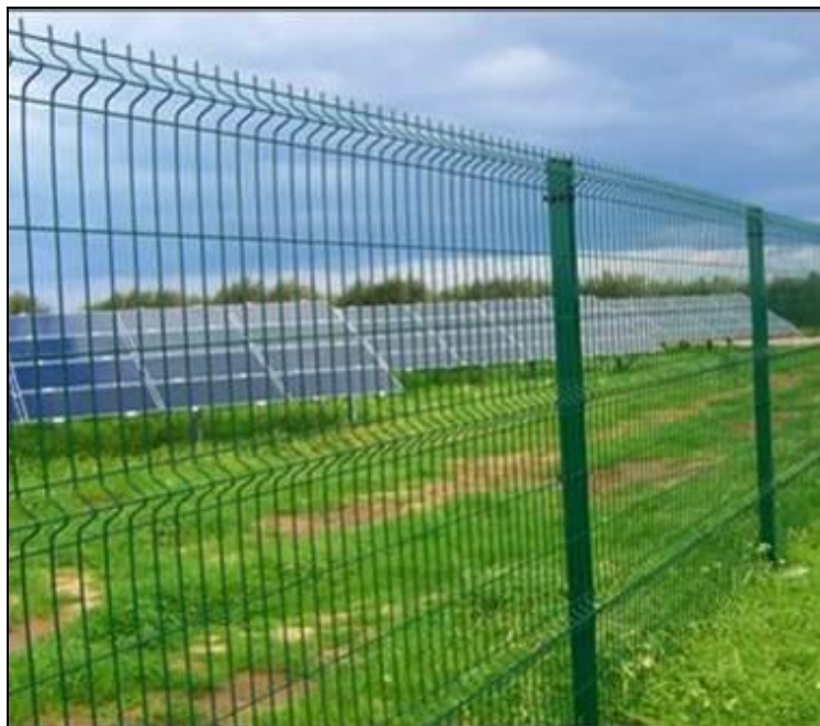
Figura 6-1- Esempi di recinzioni per impianti fotovoltaici a terra
