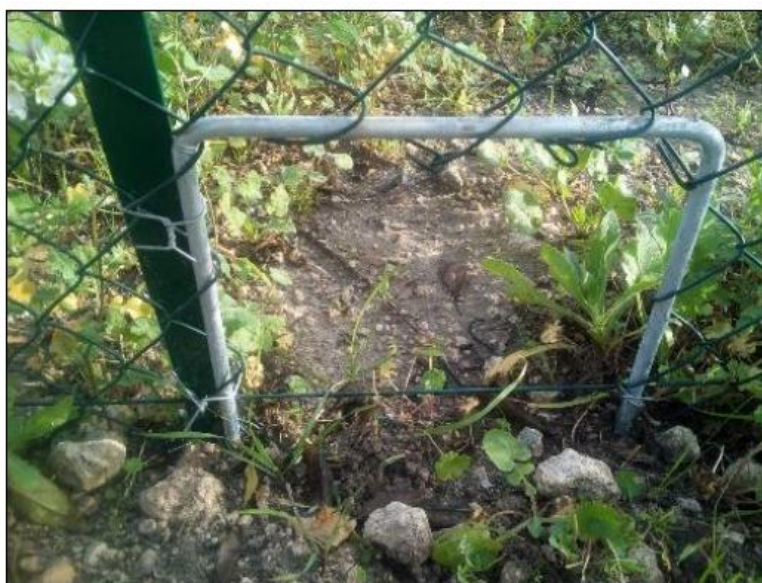
Figura 6-2 – Esempio di passaggio per la fauna lungo la recinzione
